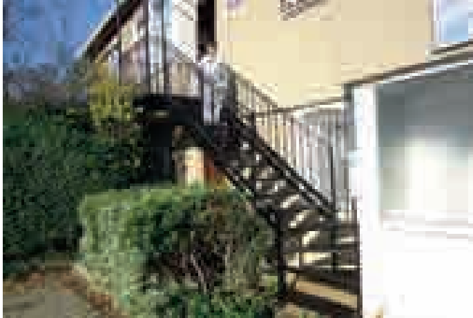
Cezayirli Gazi Hasan Paşa Cami Metal Merdiven
