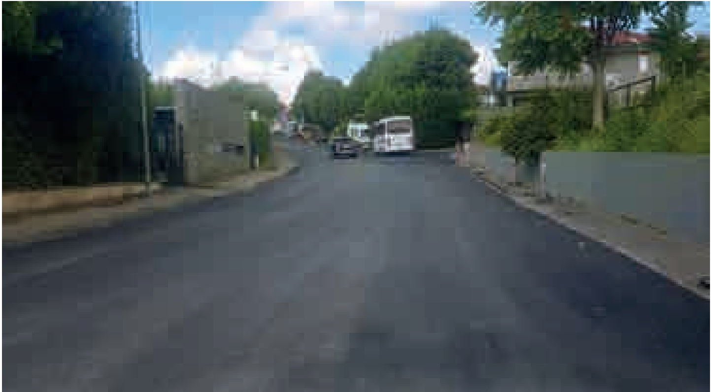
Poligon, Tepeüstü Sokak, Asfalt Çalışması
