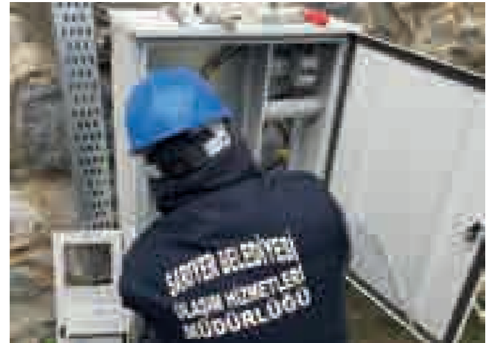
Ferahevler Spor Kulübü Elektrik Panosu Montajı
