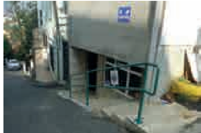
Kazım Karabekir Orta Cami Merdiven Korkuluğu
