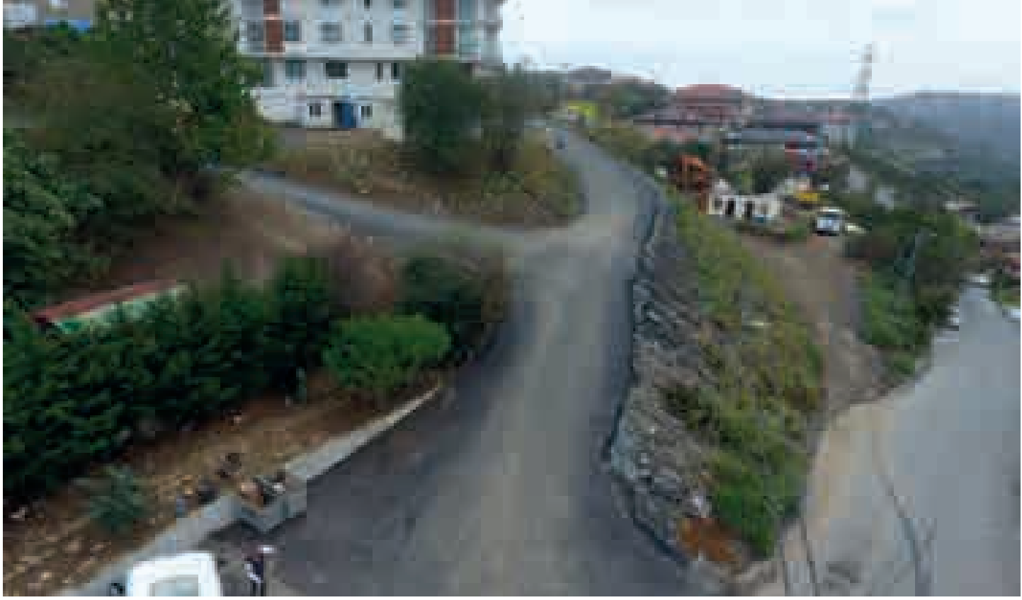
Maden, Kızılelma Sokak, Asfalt Çalışması
