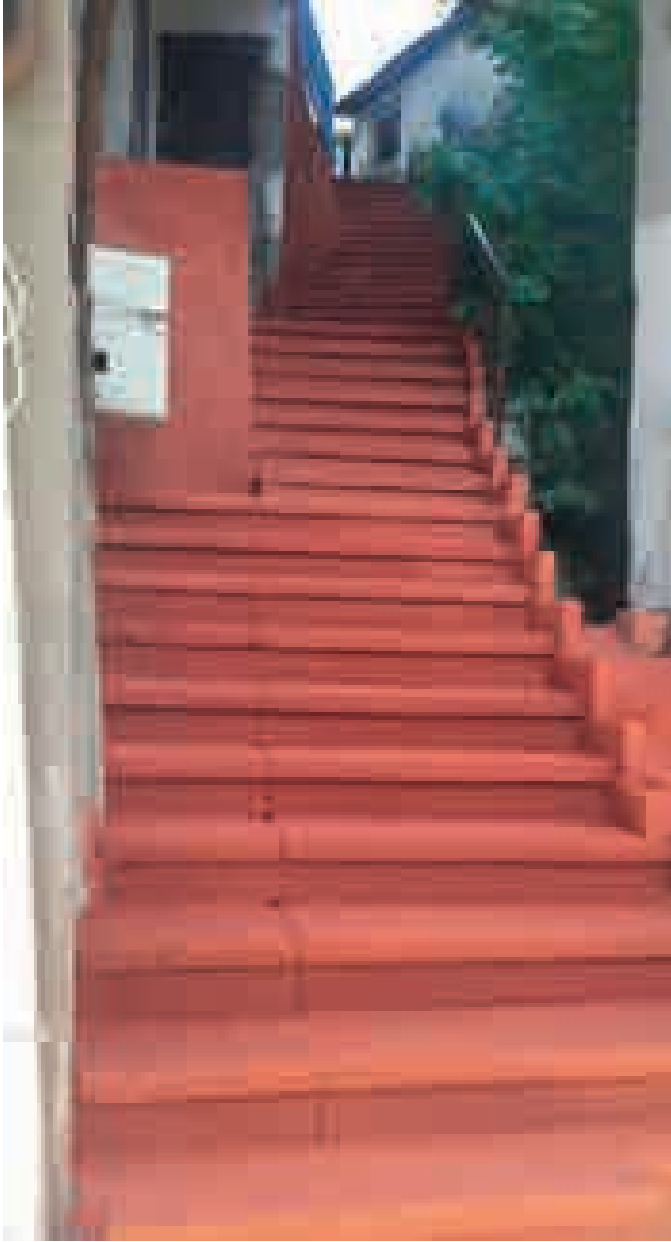
Ayazağa, 113. ve 114. Sokak Bağlantı Merdivenleri
