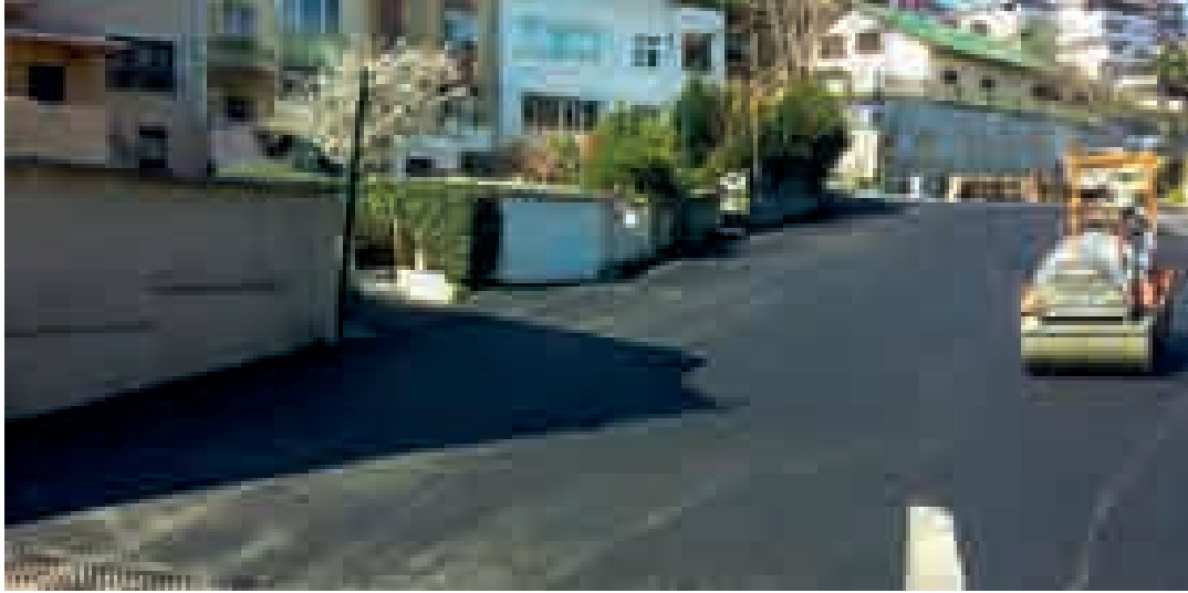
Reşitpaşa, Botancı Sokak, Asfalt Çalışması
