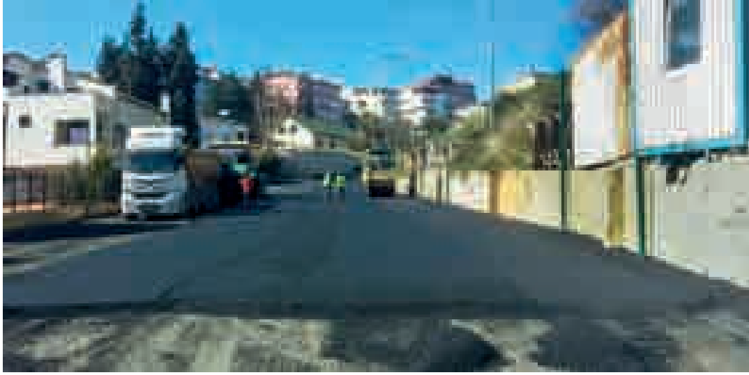
Reşitpaşa, Botancı Sokak, Asfalt Çalışması
